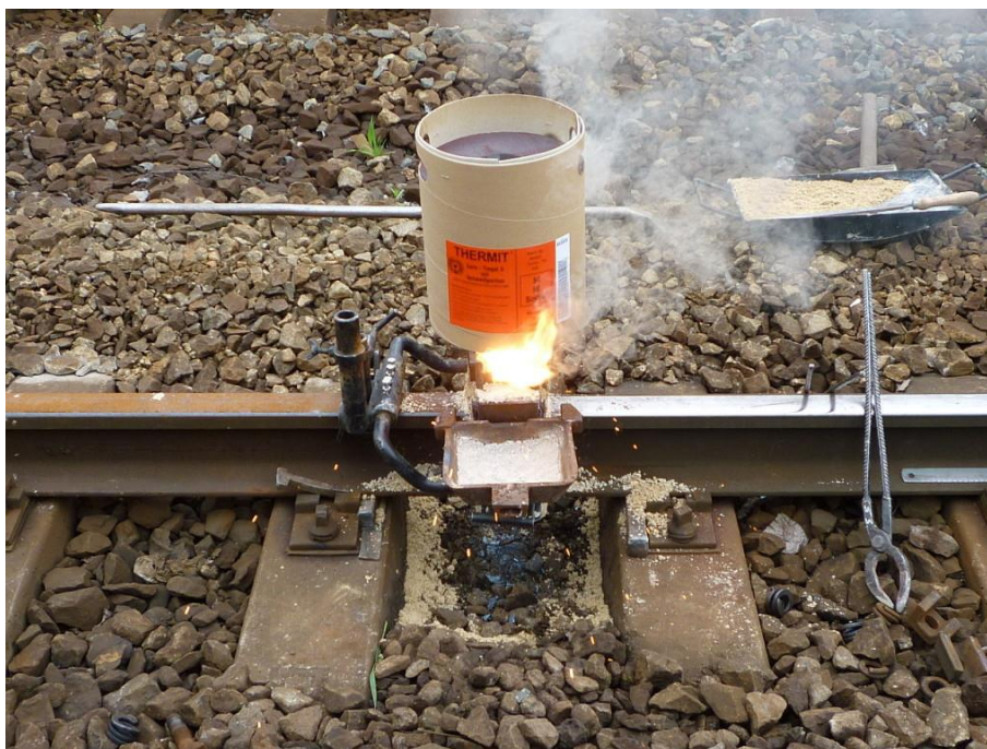
Рис. 4.28. Оборудование для термитной сварки
