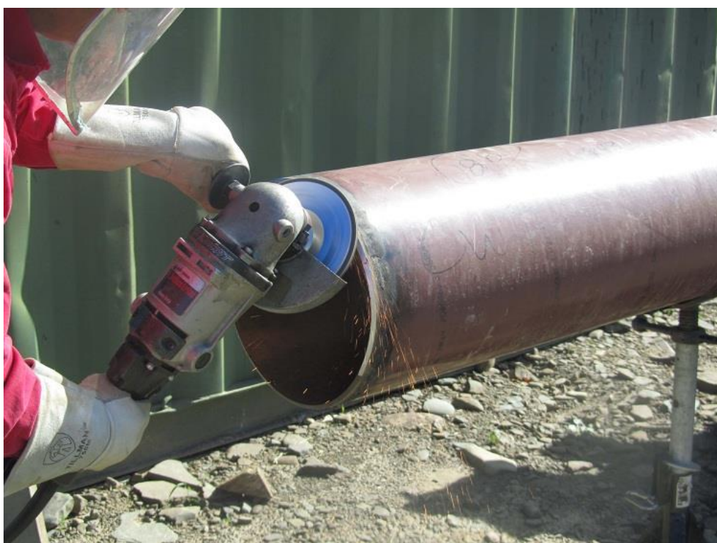
Рис. 4.3. Зачистка металла перед сваркой
